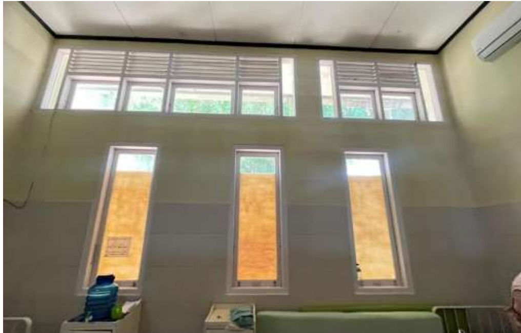
Gambar 4. 16 (Tampak Jendela dan Ventilasi) (Dokumentasi Pribadi, 2026)
