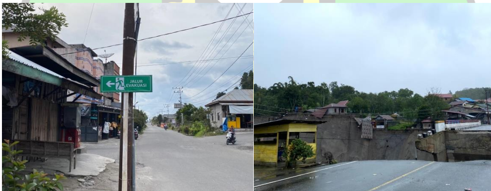
Gambar 4. 5 Rambu Jalur Evakuasi dan Kondisi Jalur Evakuasi yang Terputus
