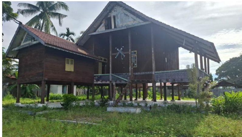
Gambar 4.9 Bentuk Fisik Rumah Adat Alas (Sumber: Dokumentasi Pribadi Penulis, 2026)
