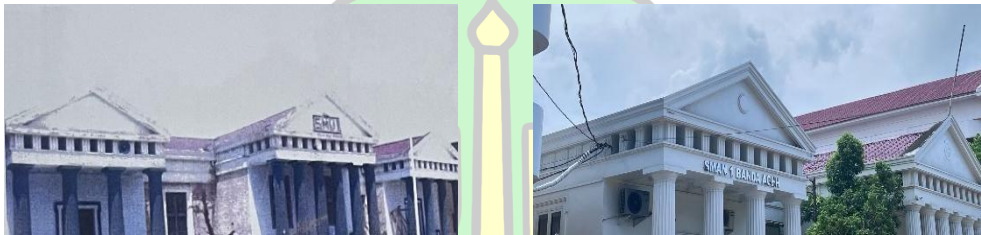
Gambar 4.14 Perubahan Material Penutup Atap Sebelum dan Sesudah Renovasi
