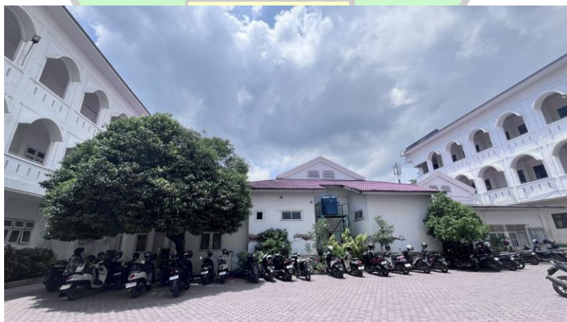
Gambar 4.2 Tampak Belakang Bangunan SMAN 1 Banda Aceh
