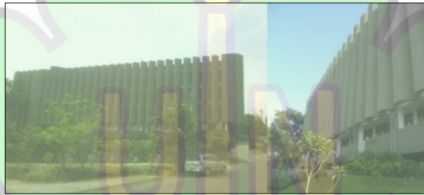
Gambar 2.4 Contoh Sirip Vertikal pada Fasad Bangunan (Sumber: Mamostudio (2025), diakses melalui mamostudio.id/ )
