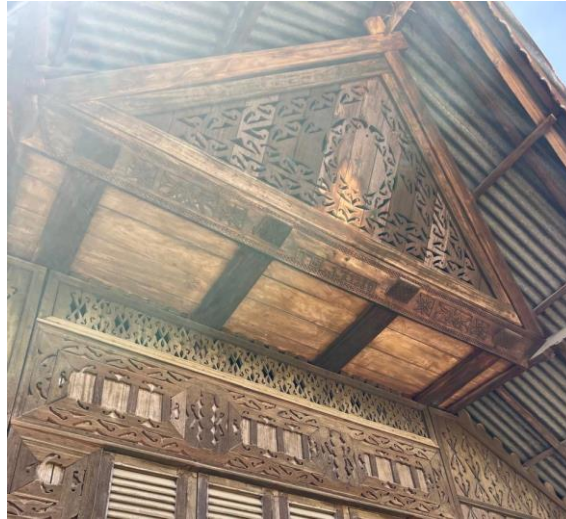
Gambar: IV.31 Tampak Atap Seng bergelombang Rumoh Aceh Biasa
