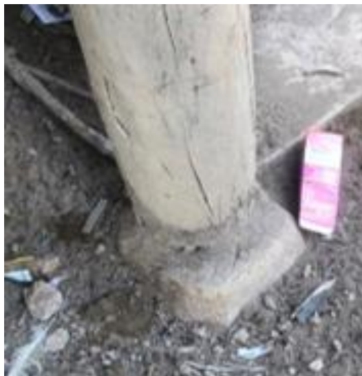
Gambar: IV.23 Sistem pondasi Rumoh Aceh Biasa
