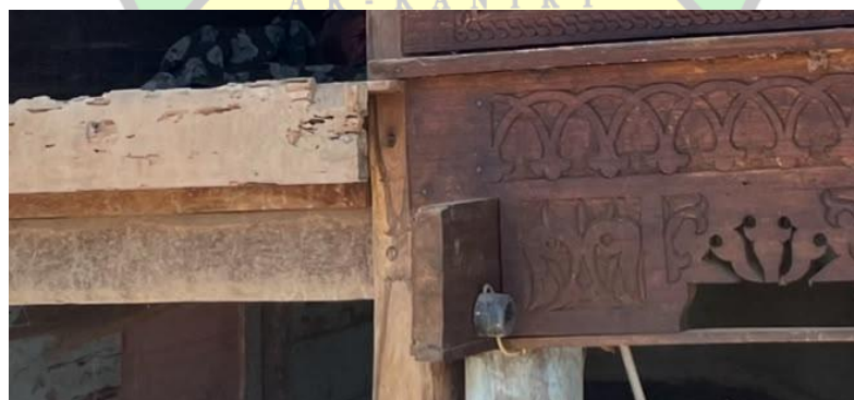
Gambar: IV.20 Struktur sambungan Rumoh Aceh Biasa
