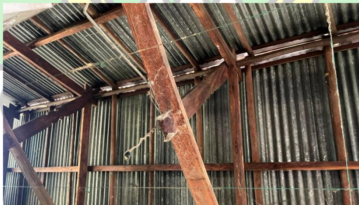
Gambar: IV.25 Struktur Atap Rumoh Aceh Biasa
