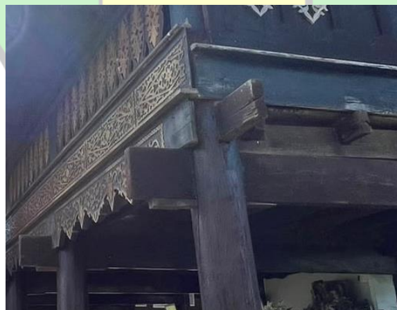
Gambar: IV.21 Struktur sambungan Rumoh Aceh Bangsawan
