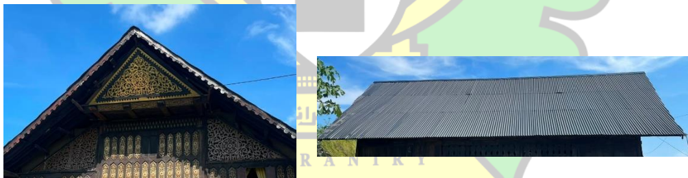
Gambar: IV.28 Tampak Atap Rumoh Aceh Bangsawan
