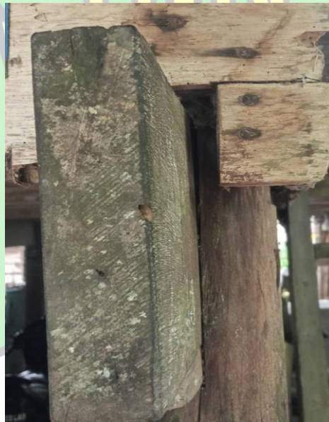
Gambar: IV.22 Struktur sambungan Rumoh Aceh Ulee Balang (Raja)
