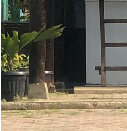
Gambar: IV.24 Sistem pondasi Rumoh Aceh Biasa
