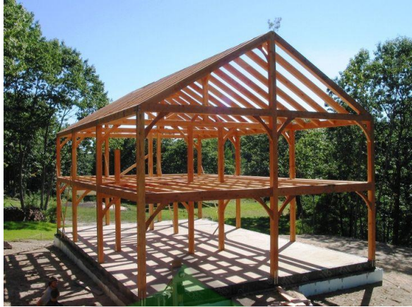
Gambar 4. 42 Struktur rangka (Sumber : Analisa Pribadi, 2025)
