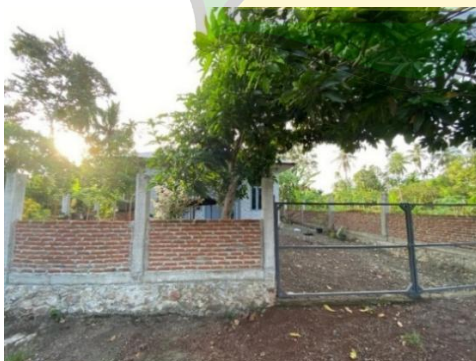
Gambar 4.4 Rumah warga (Sumber: Dokumentasi Penulis, 7 Juni 2026)
