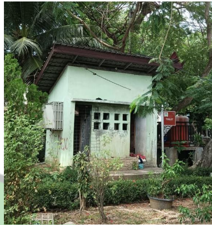
Gambar 4. 8 Kondisi Toilet Sumber: Dokumentasi Pribadi, 2026
