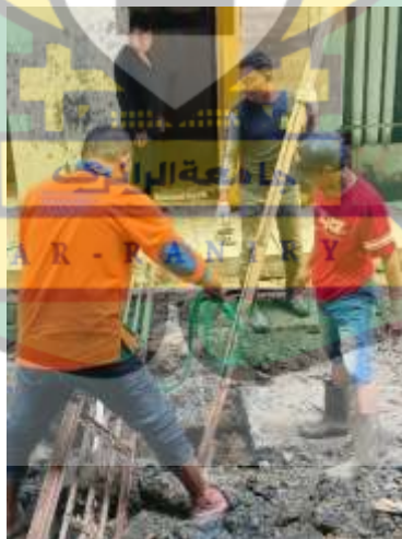
Gambar 4.4 Pembersihan Lumpur pada Bak Sedimentasi
