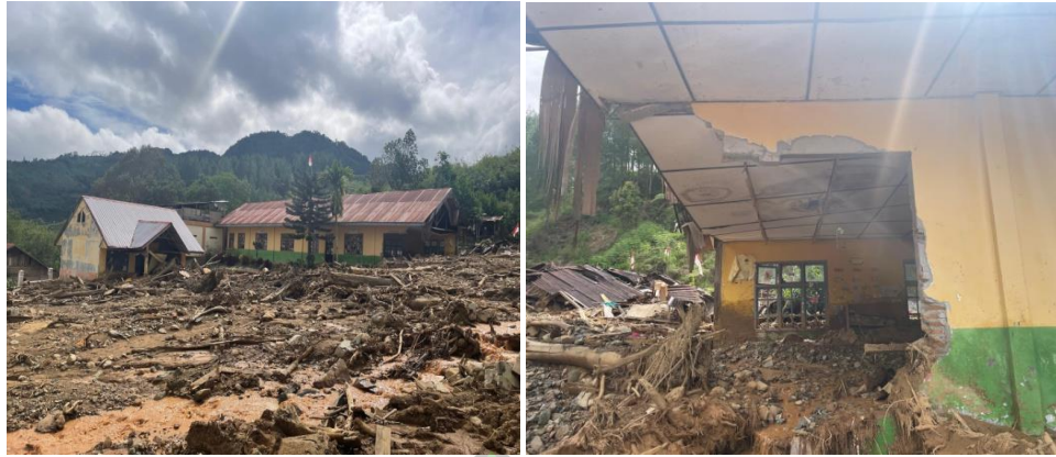
Gambar 4.7 Kondisi bangunan SD N 11 yang terdampak banjir dan longsor
