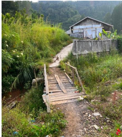
Gambar 4 .10 Jembatan sementara penghubung TK
