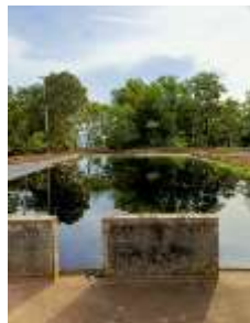
Gambar 3.2 Lokasi pengambilan sampel: Kolam Terakhir penampungan Lindi di TPA Regional Blang Bintang
