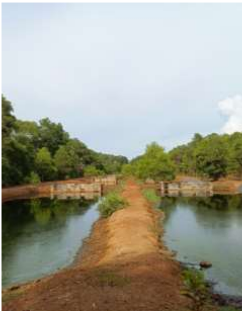
Pembatas antar kolam Penampungan
