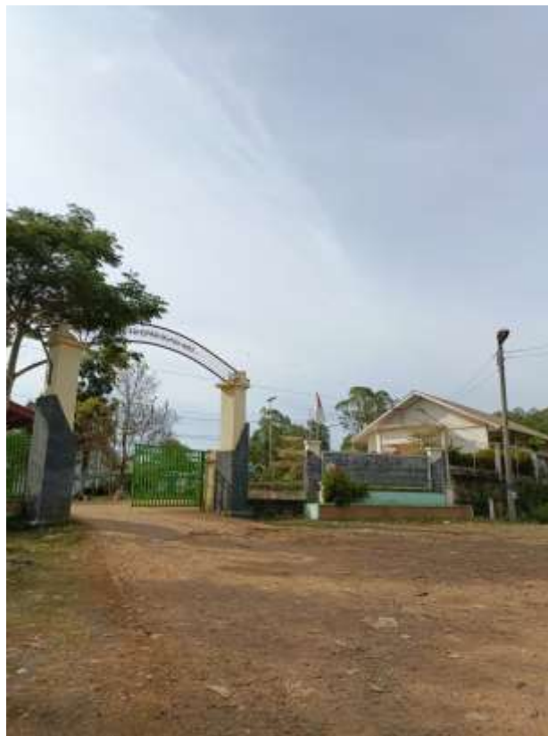
Gambar 2.1 Kondisi Eksisting TPA Blang Bintang
