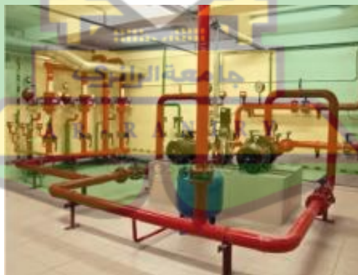
Gambar 5.21 Perpipaan Sprinkler (Sumber: Total Proteksi)
