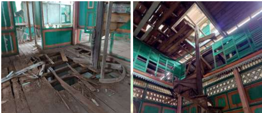
Gambar 1-12. Dokumentasi Ruang 2.C
