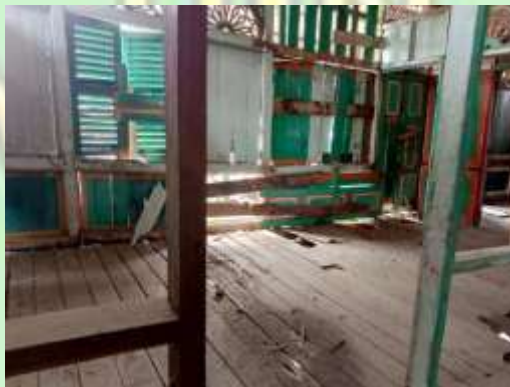
Gambar 1-14. Dokumentasi Ruang 2.E
