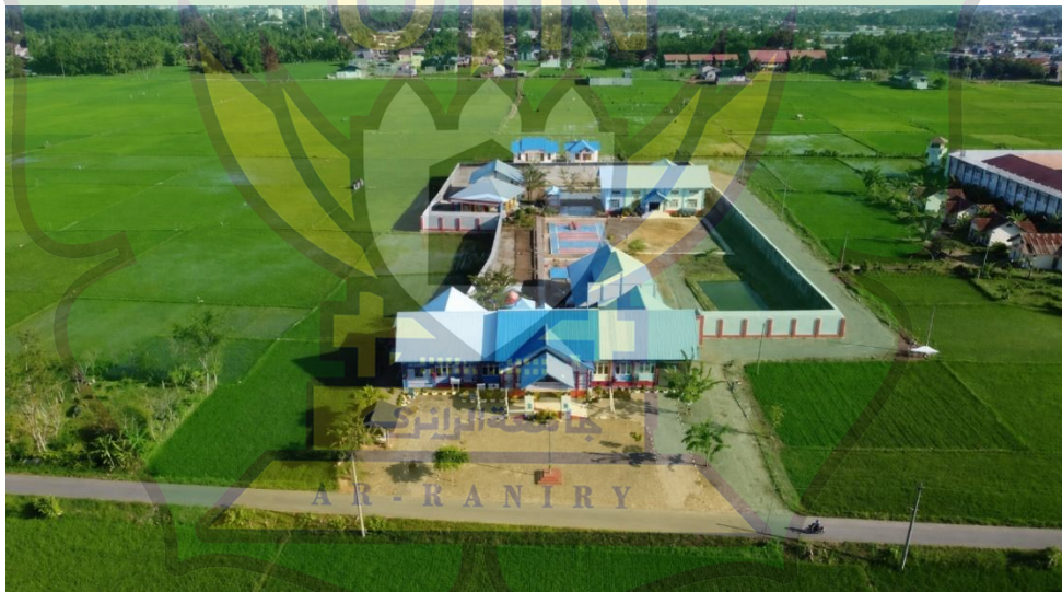
Gambar 4.2 Tampak Udara LPKA Kelas II Banda Aceh
