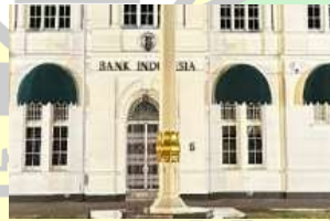
Gambar 4. 57 Bingkai pada Bukaan Pintu Gedung Bank Indonesia Aceh Sumber: (Dokumentasi Pribadi)
