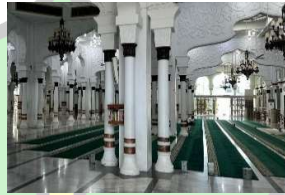
Gambar 4. 33 Struktur Kolom pada Masjid Raya Baiturrahman Sumber: (Dokumentasi Pribadi)
