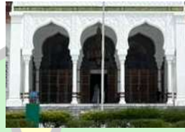
Gambar 4. 35 Struktur Kolom pada Masjid Raya Baiturrahman Sumber: (Dokumentasi Pribadi)
