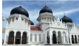
Gambar 4. 4 Elemen Struktur Masjid Raya Baiturrahman Sumber: (Dokumentasi Pribadi)
