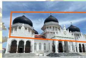
Gambar 4. 25 Bentuk Atap pada Masjid Raya Baiturrahman Sumber: (Dokumentasi Pribadi)
