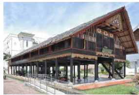
Gambar 4. 42 Struktur Kolom dan Balok Rumoh Aceh Sumber: ( https://indonesiakaya.com , 2026)
