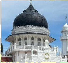
Gambar 4. 29 Struktur Kubah pada Masjid Raya Baiturrahman Sumber: (Dokumentasi Pribadi)
