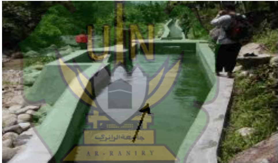
Gambar 2. 3 Bak pengendap dan penenang (Sumber: https://resashogi.blogspot.com )
