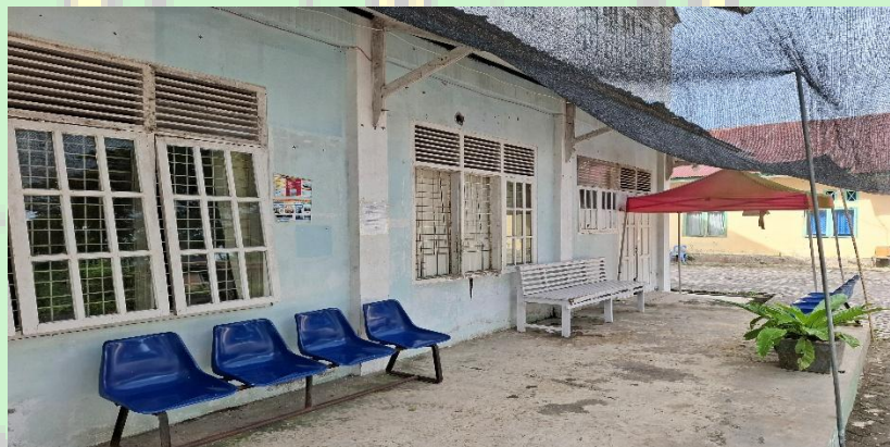
Gambar 4.6 Bagian Pendaftaran Rawat Jalan
