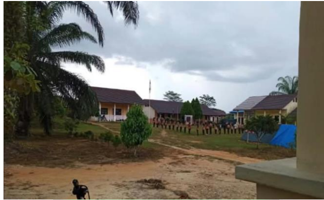
Gambar 7. Kondisi Area Sekolah
