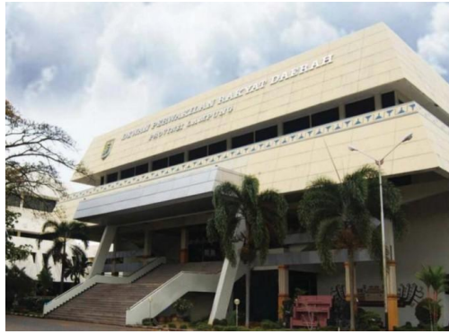
Gambar 1. 6: Bentuk Gedung DPRD Lampung yang menerapkan identitas daerah kedalam bangunan
