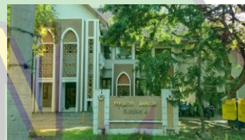
Gambar 4 Gedung FTK A
