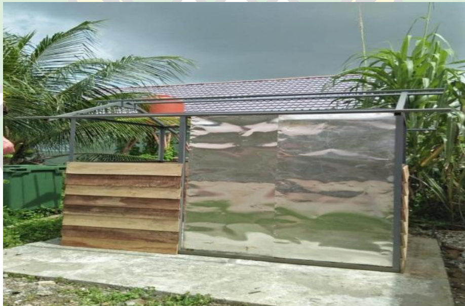
Gambar 4. Depo WCP yang Sedang Dibangun
