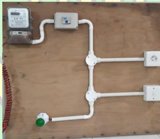
Gambar 4.2 instalasi listik rumah sederhana
