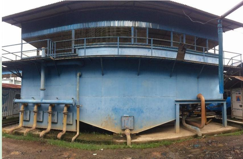
Gambar 1. Bak sedimentasi dan bak filtrasi
