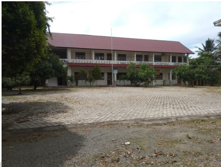
( Bangunan Kantor Dewan Guru dan Kelas XII )
