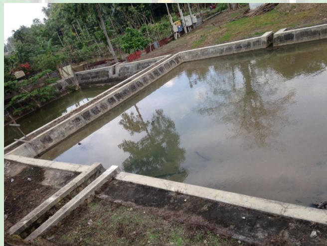
Gambar 4.12. Bak Penampung Lumpur IPA Pria Laot
