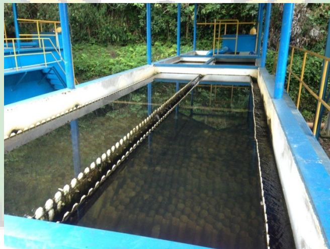
Gambar 4.6. Bak Sedimentasi IPA Pria Laot
