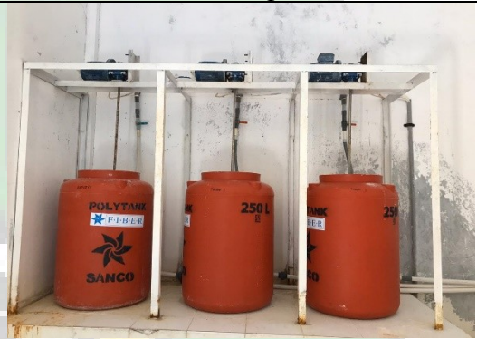
Pengadukan Koagulan dan Desinfektan
