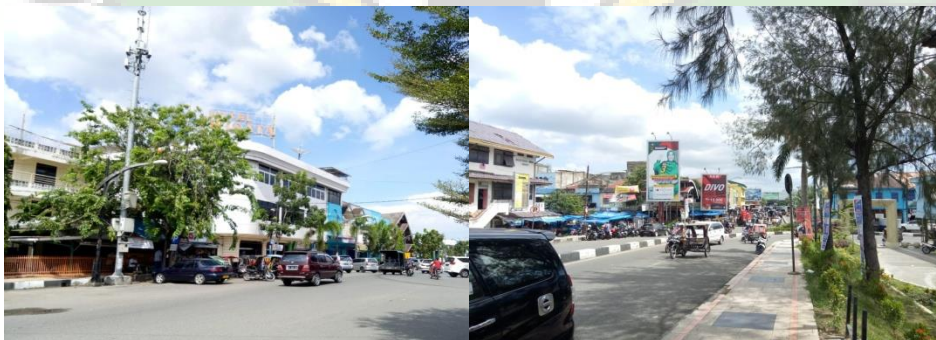
Gambar 4.7 : Utilitas Jaringan Listrik dan Drainase Sumber : Dokumen Pribadi 2018
