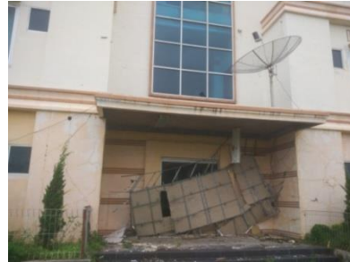
Gambar D: Teras kanopi roboh
