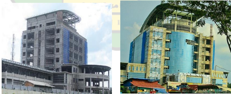
Gambar 2.14: Tahap Pembangunan Sumber: www.utusanriau.co/?/det/5310 (15 Januari 2018)
