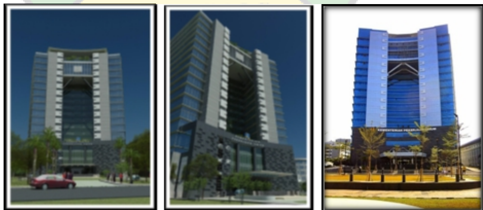
Gambar 2.7: Bangunan Kantor Kementerian Pekerjaan Umum
