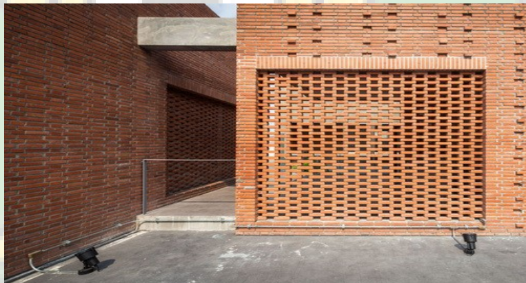
Gambar 4.12 Dinding Berpori Sumber: http://architectaria.com/desain-rumah-dengan-kisi-batu-bata-yang-menyamarkan-area-outdoor.html/rumah-kisi-batu-bata-3 , diakses 20/12/2019
