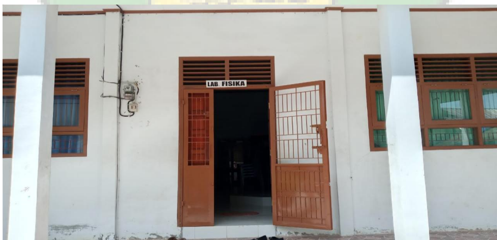
Gambar.6 Tampak depan Laboratorium Fisika
