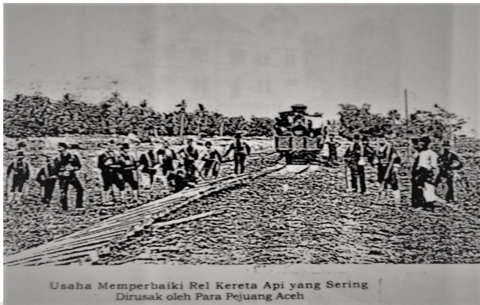
Gambar 4: Proses perbaikan rel kereta api yang dirusak oleh pejuang Aceh.
