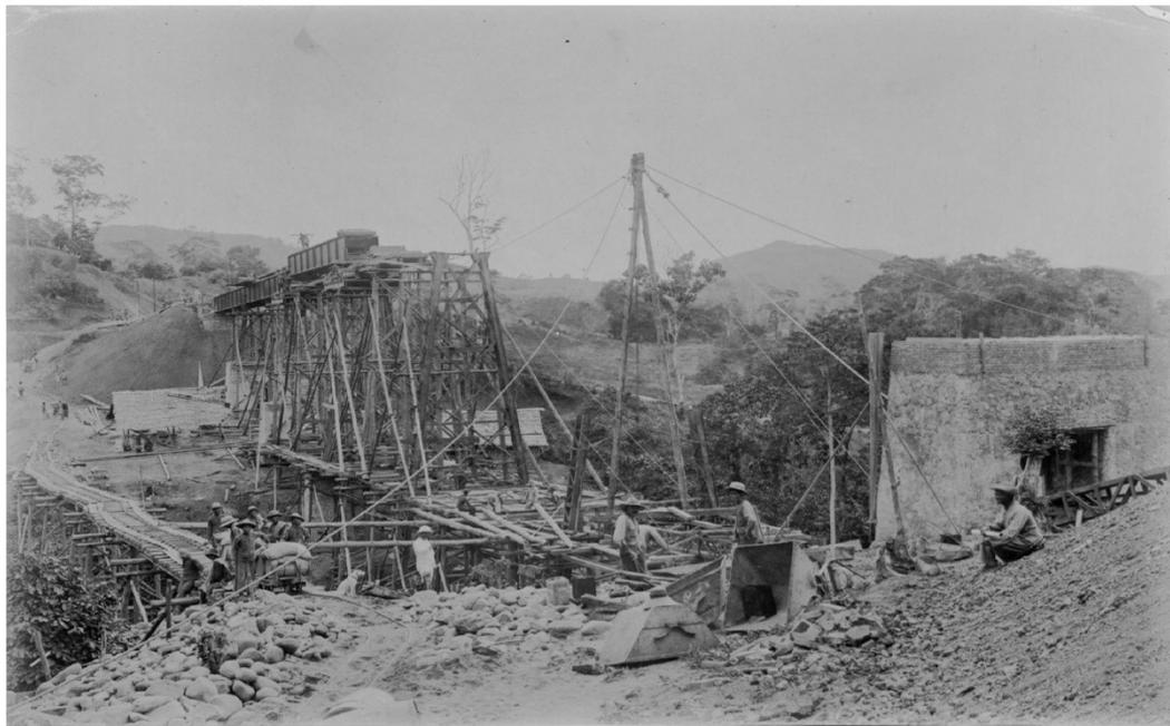
Gambar 7: Proses pembangunan jalur kereta api *Atjeh Tram*
