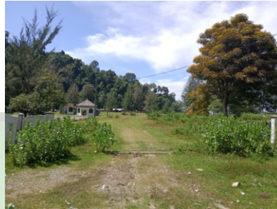
Gambar 4.4 Jaringan Listrik Sumber : Dokumentasi Pribadi, 2018
