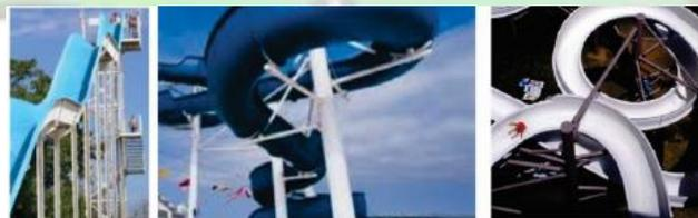
Gambar 5.24 : Struktur rangka baja penopang *waterslides*
