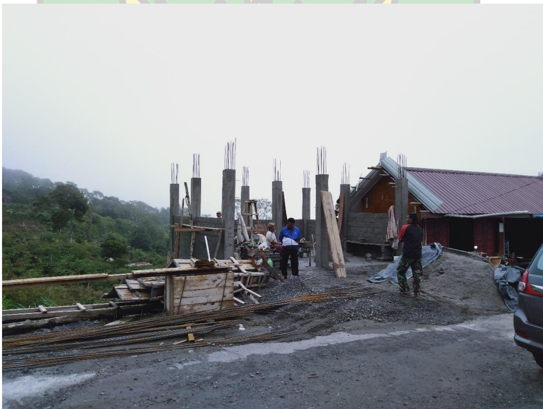
Pembangunan Kios Desa
