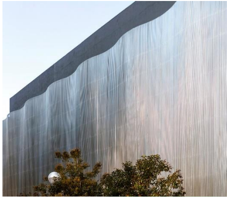
Gambar 2.13 Fasad Bagian Timur
