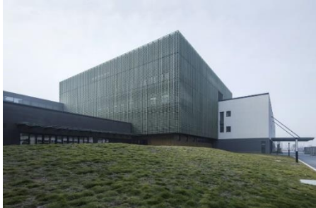
Gambar 2.23 Fasad Menggunakan Besi/Baja
