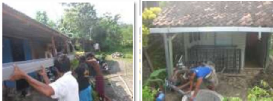
Gambar 2.6 Warga Sukorejo Gunung Pati Memasang Talang dalam Pembuatan Sumur Resapan di Halaman Rumah Warga (Sumber: Sri Mulyani dkk, 2010)
