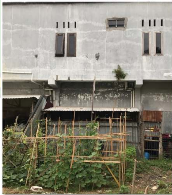
Gambar 4.4. Bangunan Rumah Toko tampak dari belakang Sumber: (Pengamatan lapangan)
