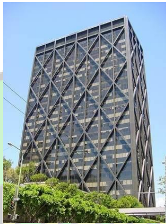
Gambar 3.7: bangunan dengan Structural Expression Sumber: www.quora.com
