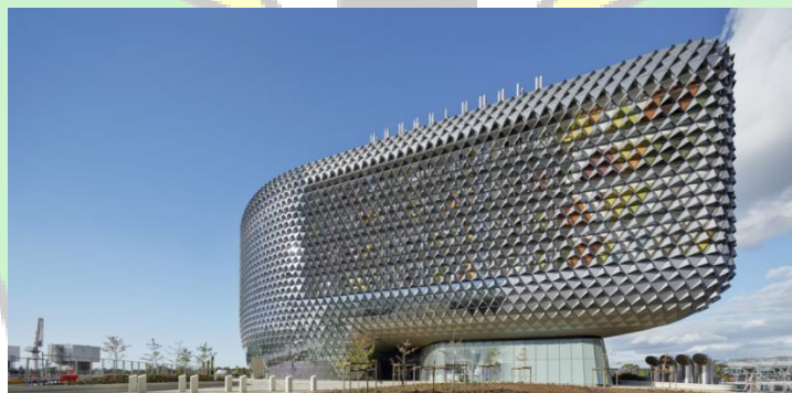
Gambar 3.15 Bentuk dari SAHMRI Building Sumber : www.woodsbagots.com
