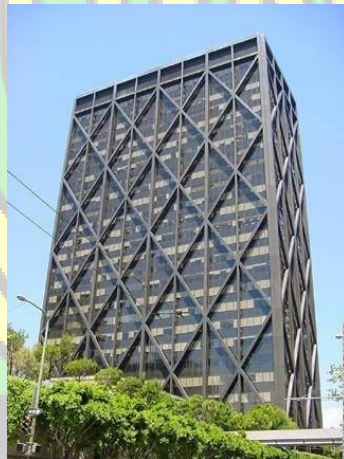
Gambar 3.7: bangunan dengan Structural Expression Sumber: www.quora.com
