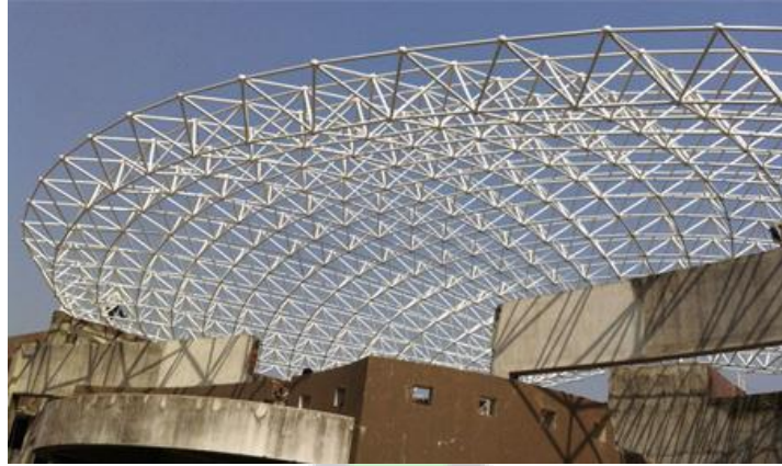
Gambar 3.6: bangunan dengan sistem bongkar pasang Sumber: www.alcox.in
