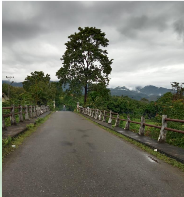
Gambar Infrastruktur Jembatan di Gampong Jantho Sumber: Koleksi pribadi, 12 Agustus 2020
