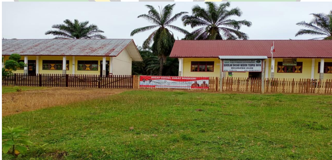
Foto 2 Bangunan SDN Teupin Raya Aceh Timur
