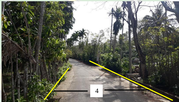
Gambar 4.14: Kondisi Jalan Ujung Kareung Sumber: Dokumentasi Pribadi
