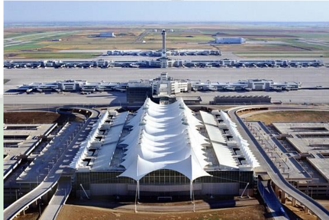
Gambar 3.8: Bandara Internasional Denver
