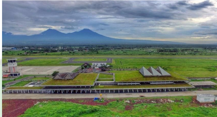
Gambar 3.14: Bandar Udara Banyuwangi
