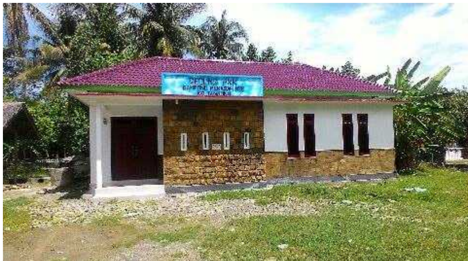
Gambar 4: Gedung PKK yang dibangun dengan menggunakan Alokasi Dana Desa (ADD) tahun 2016
