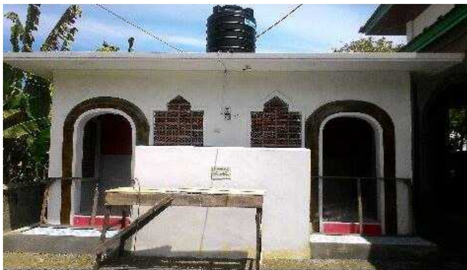
Gambar 3 : Setelah dibangun dengan menggunakan Alokasi Dana Desa Tahun 2016
