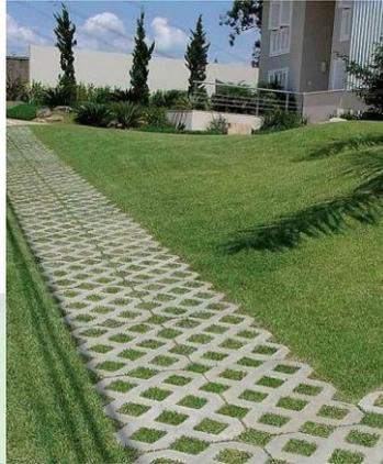
Gambar 5. 13 Pedestrian menggunakan perkerasan grass block
