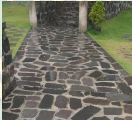
Gambar 5. 14 Pedestrian menggunakan perkerasan lempengan batu alam
