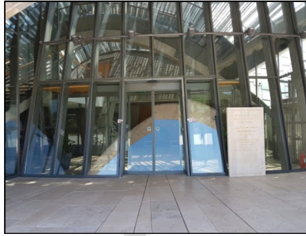
Gambar 2.13 : pintu masuk utama Sumber : https://archnet.org
