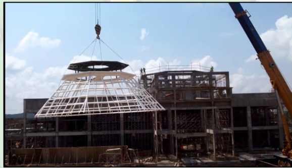
Gambar 3.6 : Proses Pemasangan kubah Masjid Cyberjaya sumber : https://i.ytimg.com/
