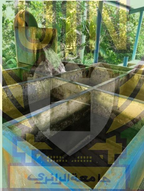
**Gambar 4.4.** Bak Sedimentasi IPA Tangan-Tangan PDAM Gunung Kila
