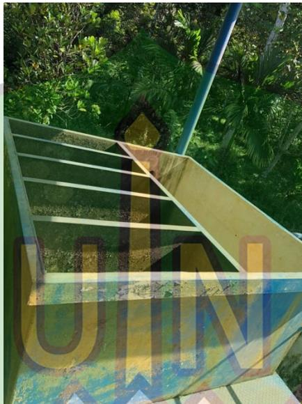
**Gambar 4.8.** Bak Filtrasi IPA Tangan-Tangan PDAM Gunong Kila
