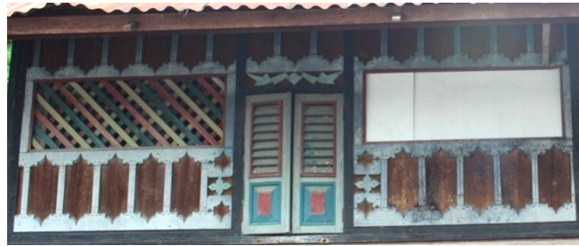
Gambar 4.27: Sisi dinding dapur timur
