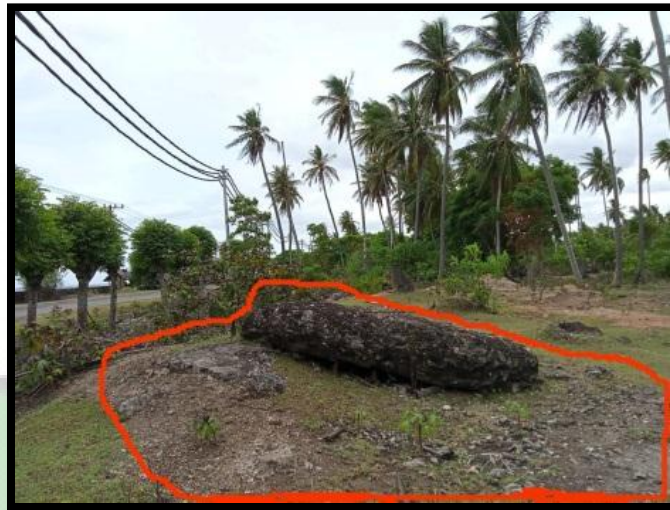
Gambar 3. 4. Posisi BML 5 di area perkebunan masyarakat, Gampong Durung. Kondisi BML 5 hanya tinggal struktur dasar saja dengan ketebalan 70 cm. selain itu, besi pada struktur sudah terlihat pada petunjuk panah warna merah. (Dok. Penulis 1 Agustus 2021)
