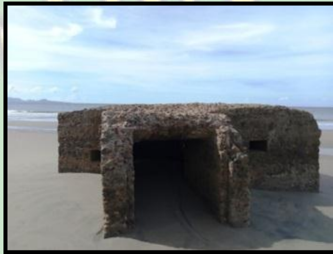
Gambar 3. 2. Posisi BML 3 berada di laut belakang sekolah Poltekpel Malahayati, Gampong Durung. BML 3 memiliki pintu masuk dari arah selatan menuju ruangan, kemudian BML 3 terdapat lima lubang pengintaian yaitu dua dari arah selatan, satu dari barat, satu dari timur, dan satu dari arah utara. Ketebalan dinding benteng berukuran 40 cm. (Dok. Penulis 8 Agustus 2021)
