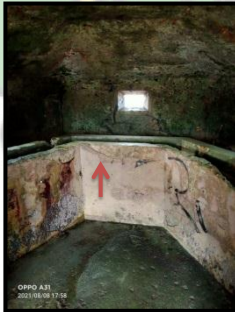
Gambar 3. 8. Posisi BML 7 terlihat semua bentuk ketika air laut surut, dan BML 14 terlihat dalam laut ketika air surut. kedua struktur BML sama bentuknya. Dalam BML 7 terdapat struktur yang ditandai dengan panah warna merah. BML 7 terdapat tiga lubang pengintai yaitu dari arah barat 1, timur 1, dan utara 1. Ketebalan dinding BML 7 ukuran 40 cm yang sama dengan struktur BML lainnya. Kemudian, lubang pengintai BML 14 terlihat hanya satu dari arah utara. Namun, di gambar tidak terlihat dengan jelas lubang pengintainya. (Dok. Penulis 8 Agustus 2021)
