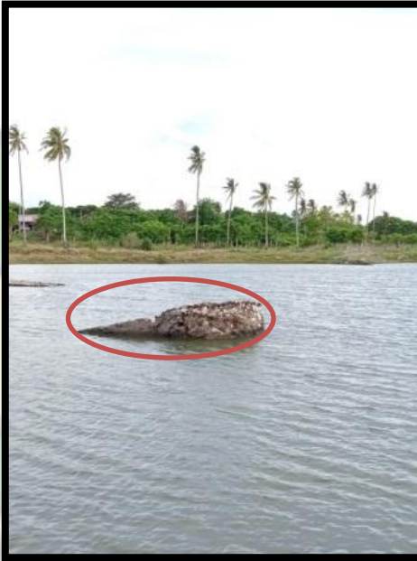
Gambar 3. 1. Posisi BML 1 berada di tengah tambak masyarakat, kondisi sudah terkikis dengan air dan ditumbuhi cangkang tiram. (Dok. Penulis 14 Agustus 2021)
