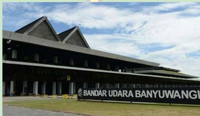
Gambar 3. 15 Bandar Udara Banyuwangi
