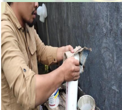
Proses pengisian media ke dalam unit filter .
