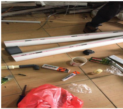
Proses pembuatan unit filter 1 dan unit filter 2
