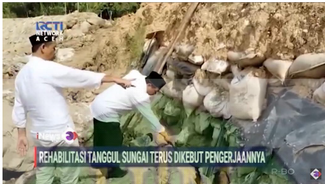
Gambar 27. Proses rehabilitasi tanggul sungai pada akhir tahun 2021
