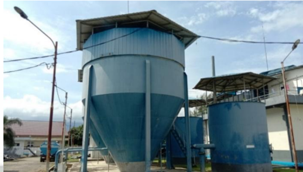
Gambar 4.9 Clarifier WKE 2 (40 l/detik)
