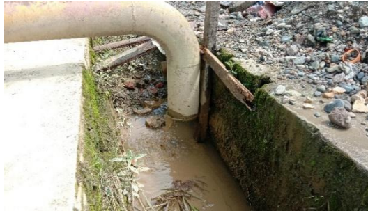
Gambar 4.11 Pipa Pembuangan Sedimen
