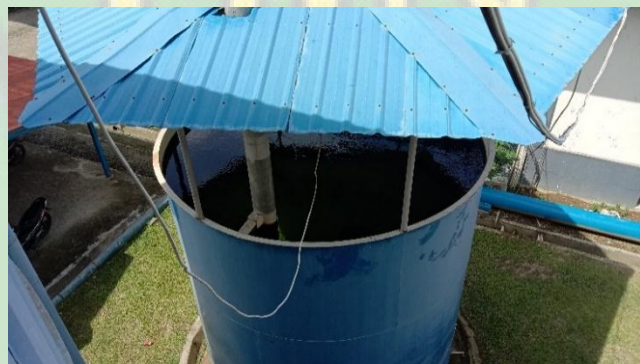
Gambar 4.10 Bak Filtrasi WKE 2 (40 l/detik)
