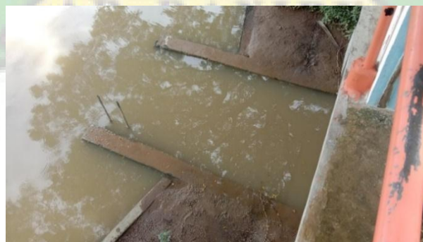
Gambar 4.5 Pintu Air Menuju Sumur Penampung (Sumber: Dokumentasi Tugas Akhir, 2020)
