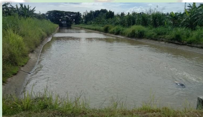
Gambar 4.4 Kolam Penampung Air (Sumber: Dokumentasi Tugas Akhir, 2020)
